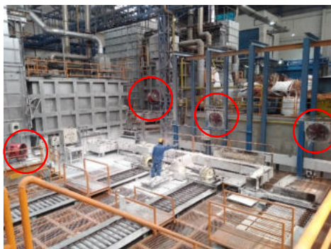
ภาพที่ 2 การติดตั้งพัดลมระบายอากาศ บริเวณเสี่ยงต่อการสะสมความร้อน
